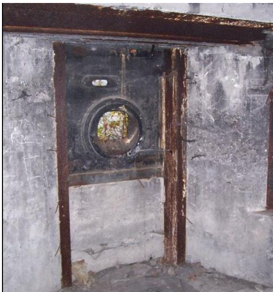
Tarcza (płyta) pancerna, po lewej ze strzelnicą z przegubem kulowym, dla armaty fortecznej wz.38 w polskim schronie bojowym Grupy Bojowej "Krzyżowa". Poniżej – tarcza (płyta) pancerna ze strzelnicą minimalną dla ciężkiego karabinu maszynowego.
