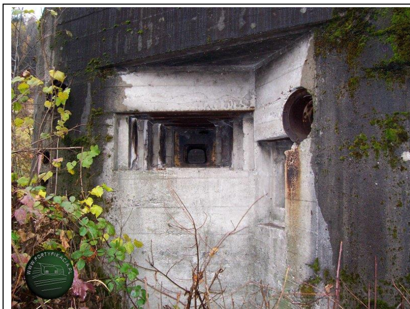
Strzelnice przeciwrykoszetowe polskiego schronu bojowego Grupy Bojowej "Krzyżowa" po lewej – strzelnica armaty fortecznej wz. 38, po prawej dla ręcznego karabinu maszynowego
